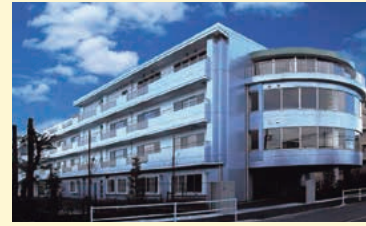
療養室は100床あり定員は入所100名、通所40名。 「訪問看護ステーション いちいの杜」を併設。
